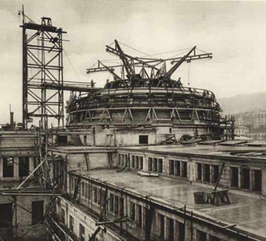
Bau der Kuppel
